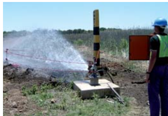
Test sur des pompes d'un nouveau puits de forage dans la zone de Vaal River afin de déterminer le volume d'eau pouvant être pompé quotidiennement
